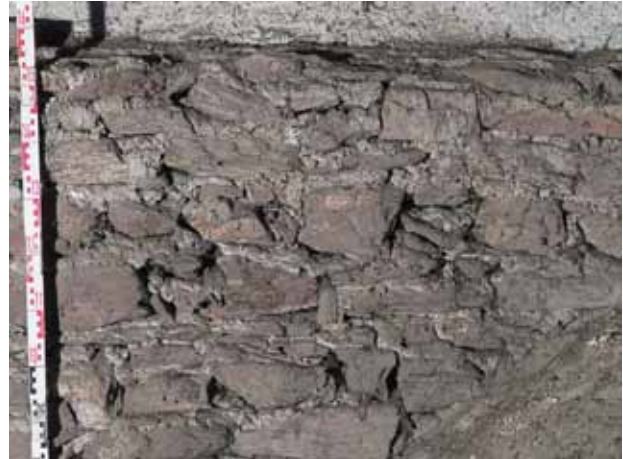
Abb. 9: Vergleichsobjekt Klarissinenkirche St. Veit, Mauerwerk im Dachraum urk. 1323, © Robert Kuttig
