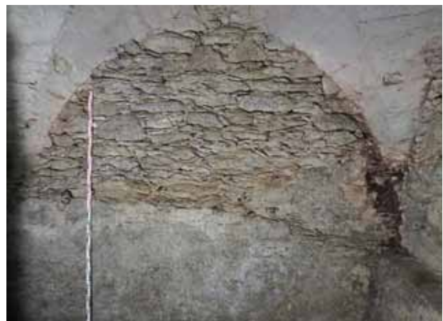
Abb. 11: Charakteristisch spätgotisch ausgezwickeltes Kellermauerwerk im Feld des Schildbogens des mit Schalungsnegativen besetzten Gewölbes, © Robert Kuttig
