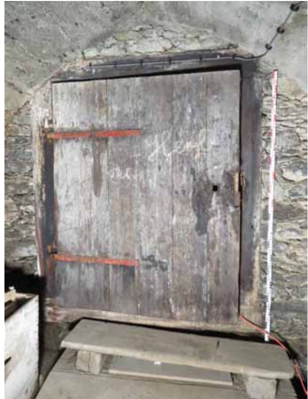
Abb. 13: Bauzeitliche spätgotische Kellertüre unterhalb der ehemaligen Stube, © Robert Kuttig
