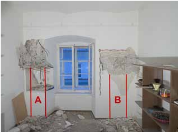
Abb. 5: Vermauerte Pfostennischen A und B der primären Pfostenstube mit Abdrücken der jüngsten Täfelung die ebenfalls verloren ist. Erstes Obergeschoß, Raum 109. Die roten Linien kennzeichnen die Negativgrenze, © Robert Kuttig
