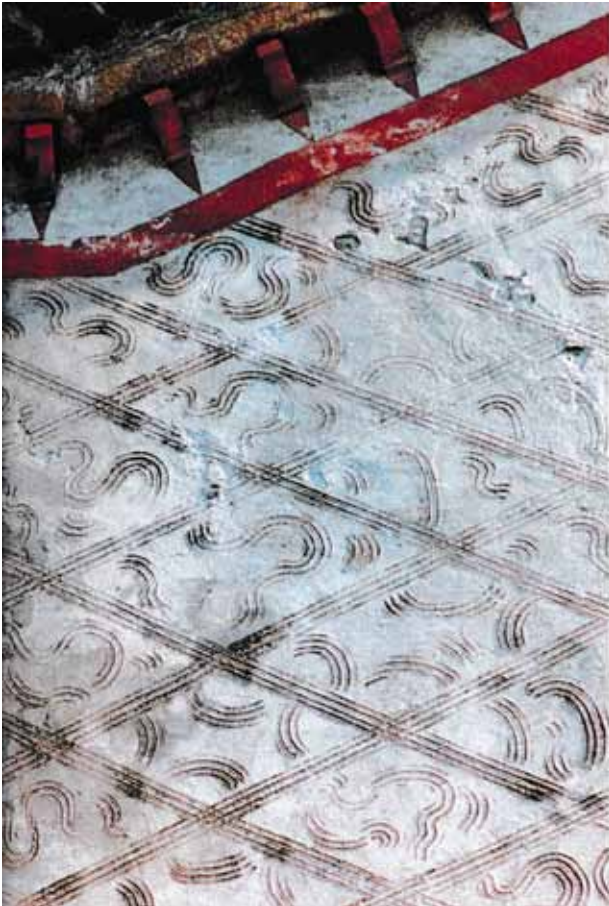
Abb. 2: Bellinzona, Tessin, Sta. Maria delle Grazie, 1480: Gekämmter Sichtputz (nach Emmenegger Abb. S. 105)
