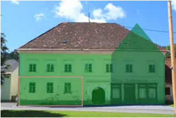
Abb. 12: Grades Am Markt 1, Hauptfassade mit dunkelgrünen Kernbau und spätgotischer Erweiterung. Die Kubatur der Pfostenstube ist mit den roten Linien herausgehoben, © Robert Kuttig
