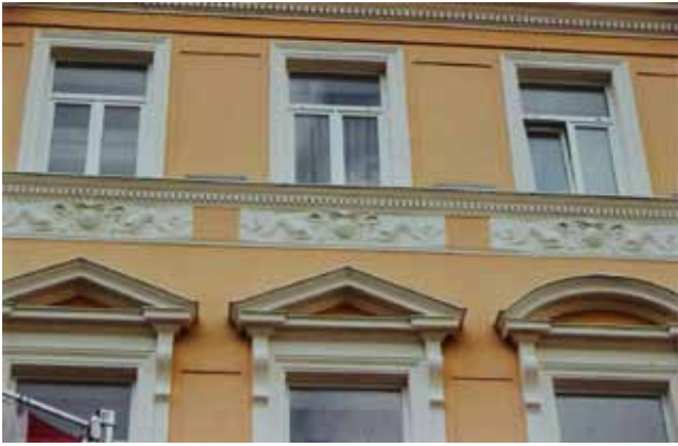
Abb. 18: Am Gesims der Ornamentfries mit den Meerestieren, Foto: D. Vasko
