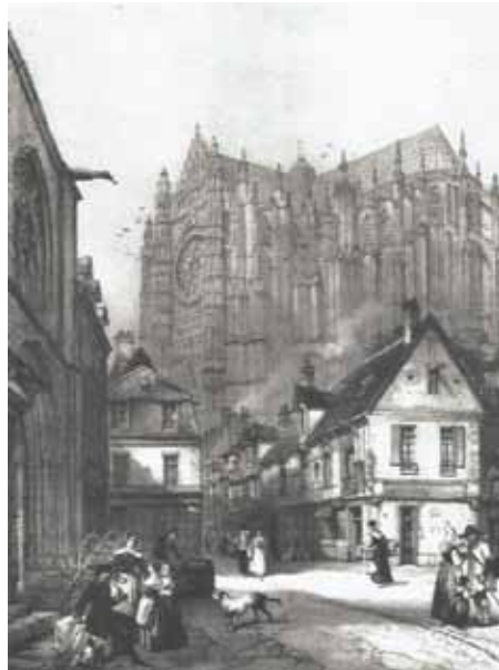
Abb. 1: Bildhafte Komposition vor strenger Konstruktion (Beauvais, Rue St. Pierre)
