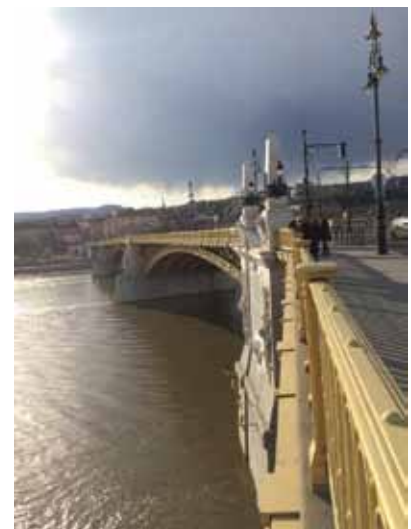
Abb. 9, 10, 11: Margaretenbrücke, Rekonstruierte Beleuchtungskörper und Oberleitung der Straßenbahn, neu aufgestellte Gusseisenkandelaber – im Hintergrund das Parlament; Rekonstruierter skulpturaler Schmuck, © Peter Bogner
