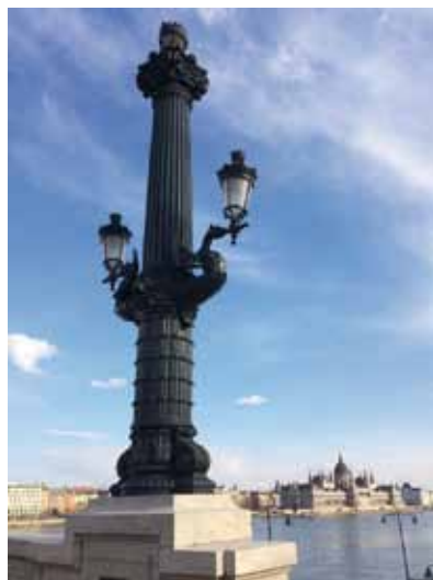
Abb. 9, 10, 11: Margaretenbrücke, Rekonstruierte Beleuchtungskörper und Oberleitung der Straßenbahn, neu aufgestellte Gusseisenkandelaber – im Hintergrund das Parlament; Rekonstruierter skulpturaler Schmuck, © Peter Bogner
