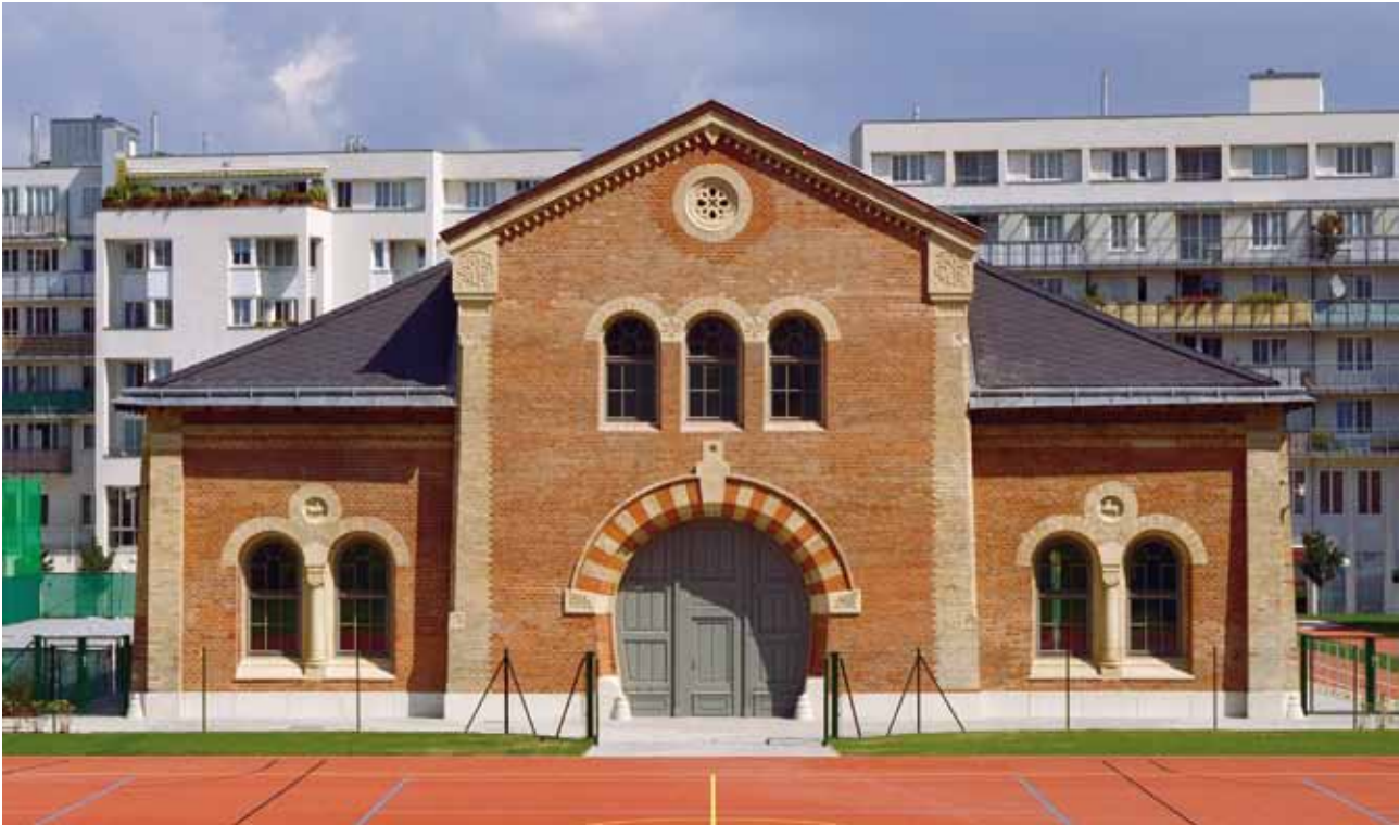
Abb. 1: ehemalige Reithalle Ansicht von der Sportplatzseite gesehen, © Loidold
