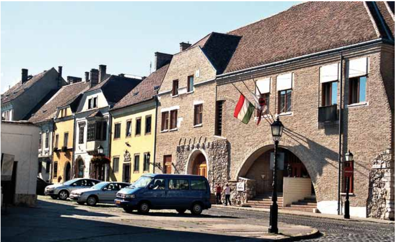
Abb. 2: Burgviertel – Wiederhergestelltes Gebäude, heute Hapimag-Stadtresidenz © Dguendel, CC BY 3.0, via Wikimedia Commons
