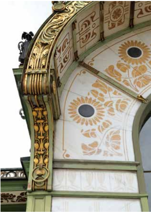
Abb. 26: Wien 4, Karlsplatz, Stadtbahnstation von Otto Wagner 1898, Neuvergoldung nach 1970, Zustand 2017, © Manfred Koller
