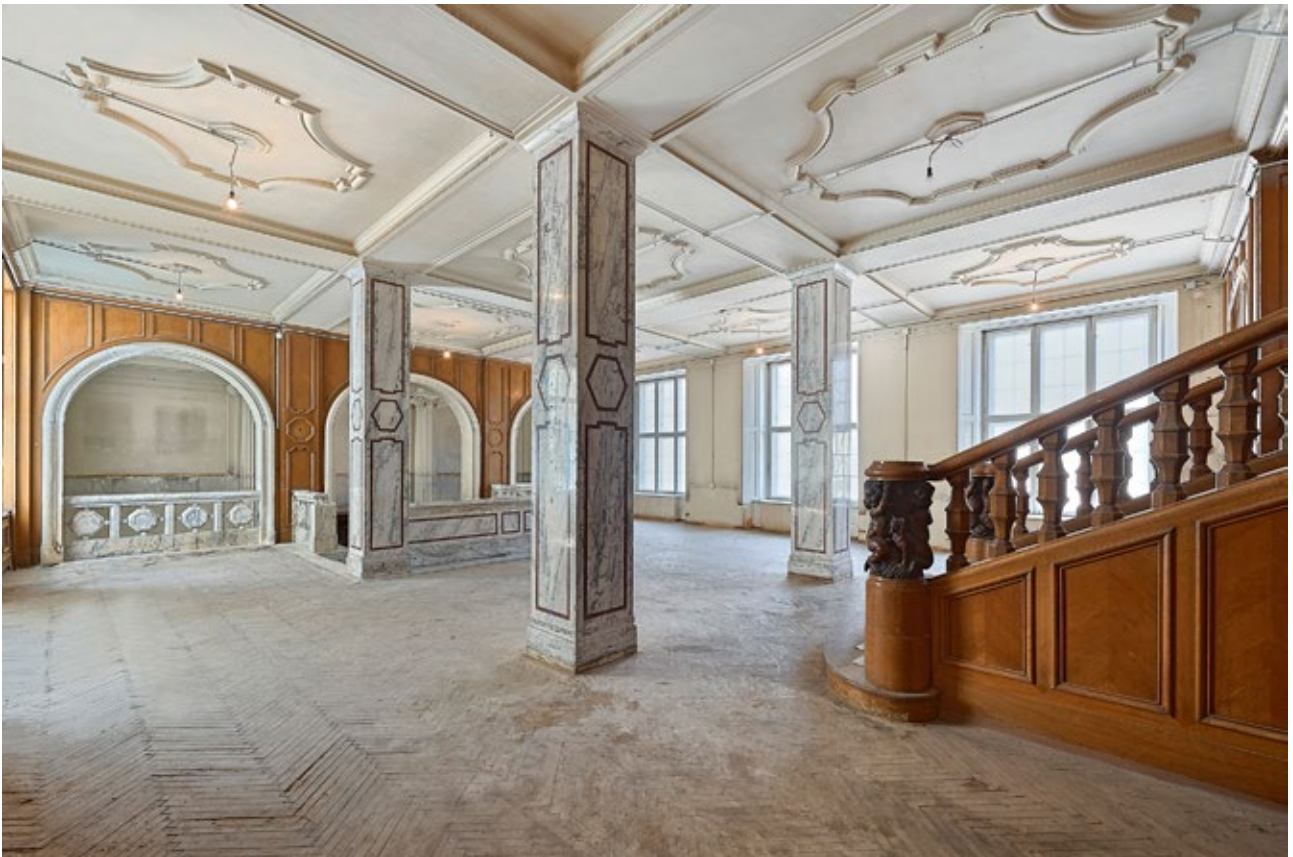
Abb. 8: Foyer in den ehemaligen Ausstellungsräumen vor der Sanierung, 2018, © Rendity GmbH, Wien
