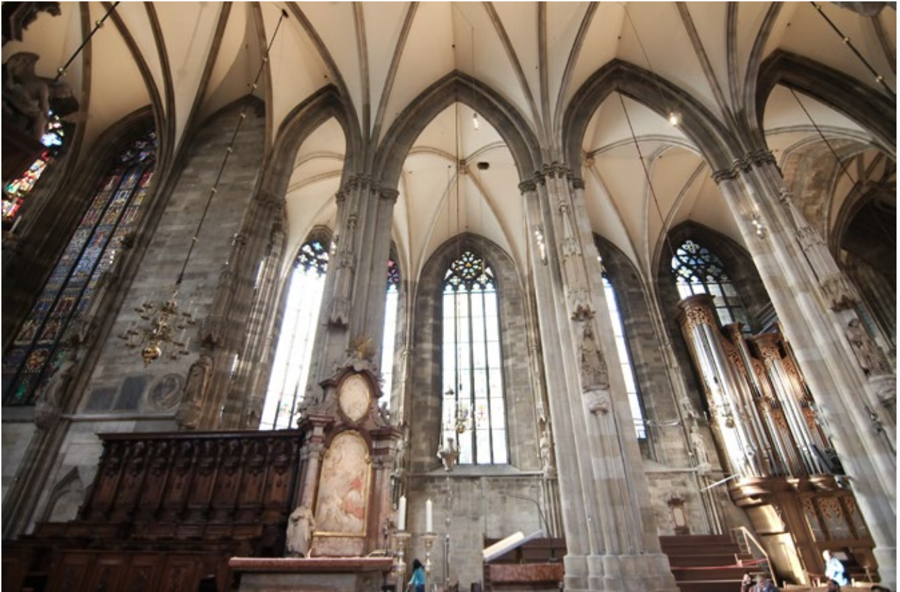
Abb. 7: Wien, St. Stephan, Albertinischer Chor, Arkadenstellung, Blick aus dem Mittelschiff in Richtung Süden, © Alfred Fischeneder-Meiseneder 2018
