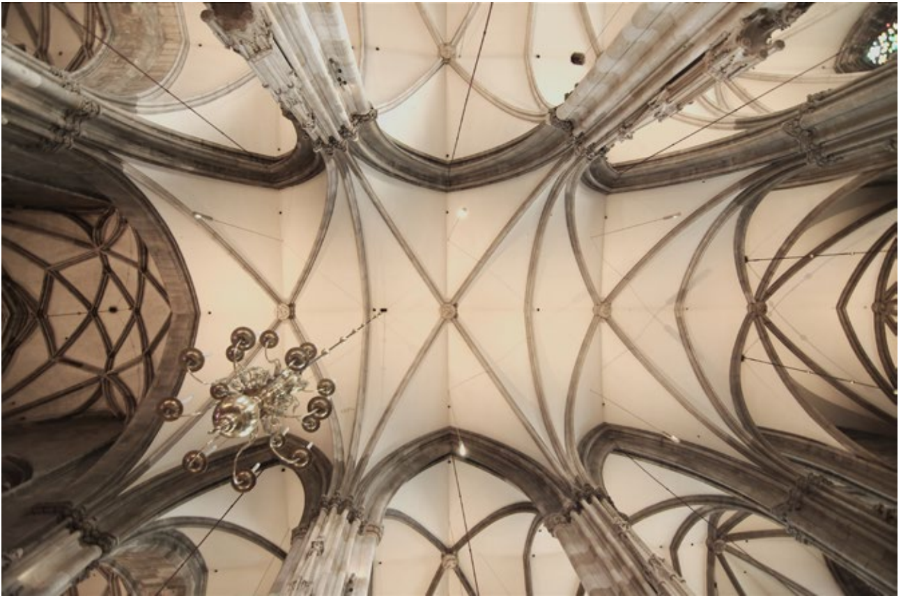
Abb. 5: Wien, St. Stephan, Albertinischer Chor, Mittelschiff, Gewölbe, © Alfred Fischeneder-Meiseneder 2018
