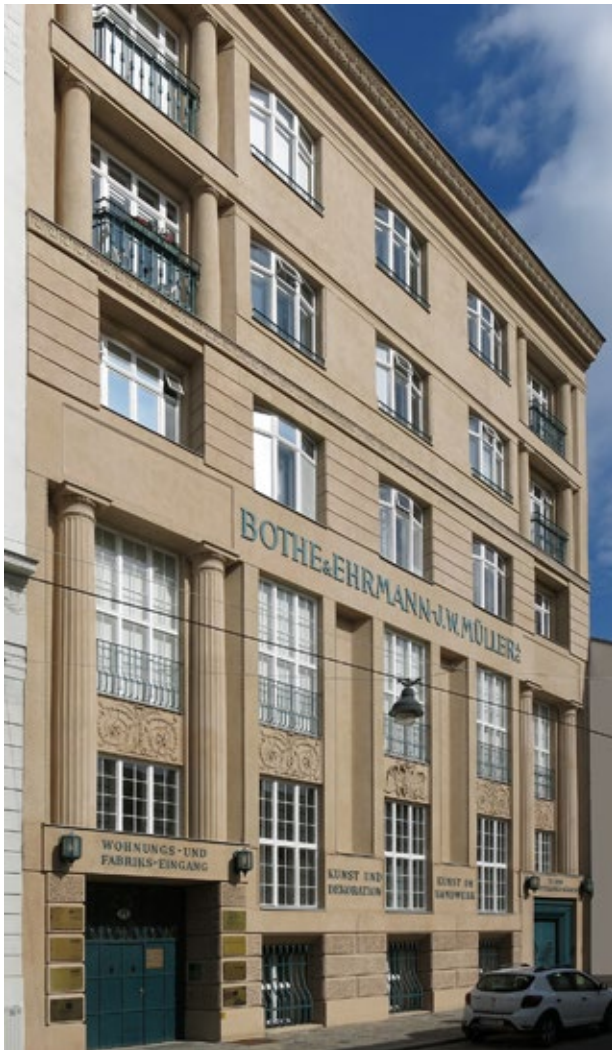
Abb. 7: Fassade Bothe & Ehrmann, Schlossgasse 14, 2019, © Foto: Stefan Üner
