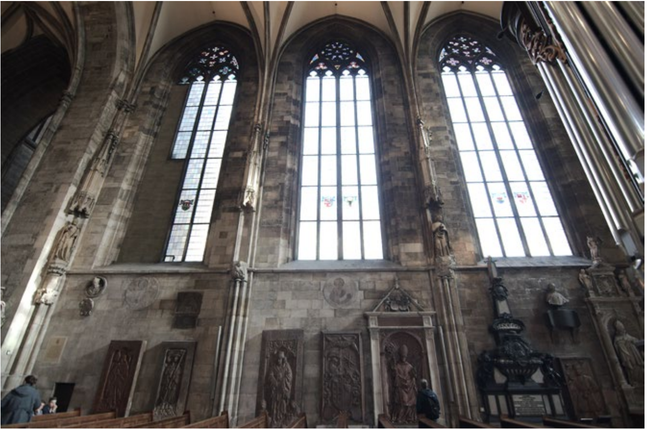
Abb. 4: Wien, St. Stephan, Albertinischer Chor, nördliche Seitenwand, © Alfred Fischeneder-Meiseneder 2018
