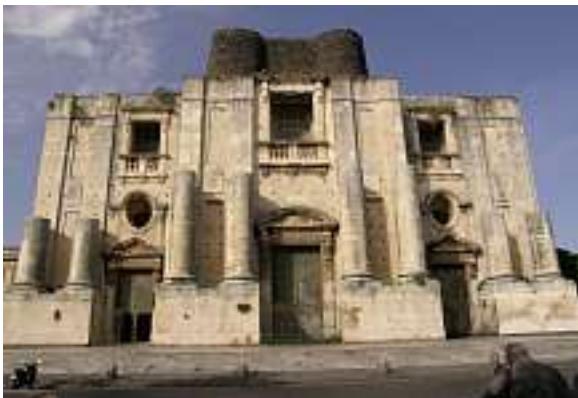
Abb. 1: Catania, Fassade der Klosterkirche San Nicola.
