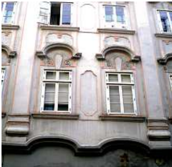
Abb. 20: Wien VII., Gardegasse 7, Fassade um 1730, erste Farbfassung (= blaugrau-rosa „Rokokophase“), nach Befund restauriert 1973, Zustand 2011 (Foto M. Koller).
