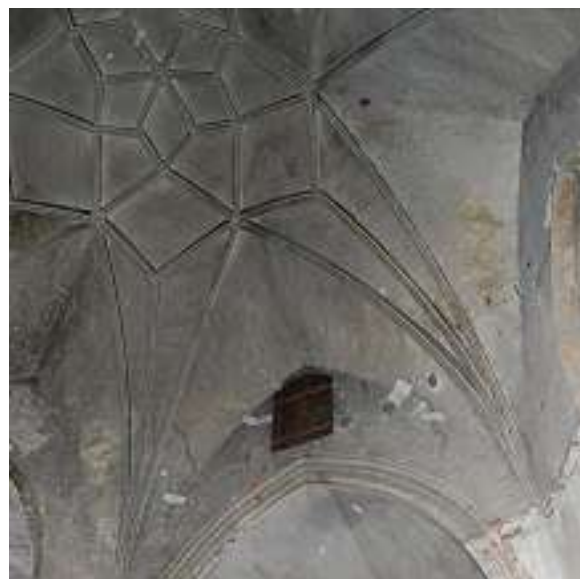
Ehem. Heiliggeistkirche in Bruck an der Mur: Sternrippengewölbe vor der Restaurierung (Februar 2014). Photo: Mario Schwarz.
