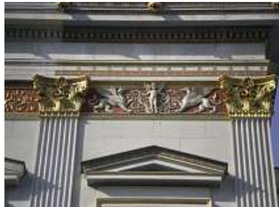
Abb. 3: Wien 1, Parlament, Südfassade, Gesims und Gebälk mit dem Ornament- und Farbkonzept Theophil Hansens, nach Restaurierung 2002 (Foto M. Koller).
