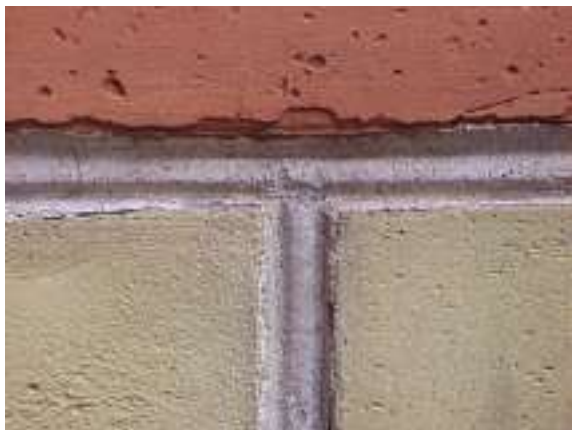
Abb. 19: Wien I, Fleischmarkt 13, Griechisch-orthodoxe Kathedrale von Theophil Hansen 1858, Fugenprofile der ursprünglichen Sichtziegelfassade (Foto M. Koller).
