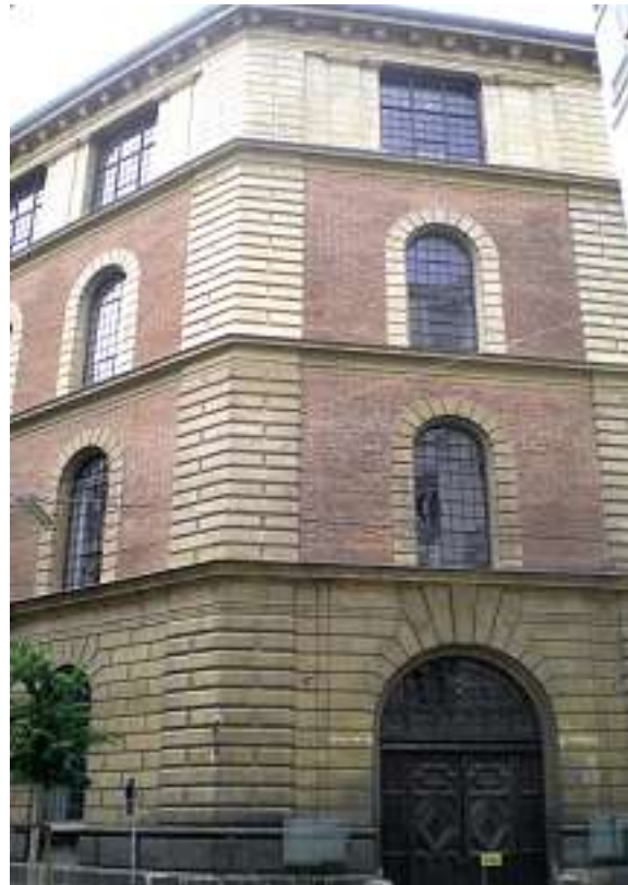
Abb. 18: Wien 6, Lehargasse, Kulissendepot von Gottfried Semper 1874-77, nach Konservierung der Originalfassade mit Steinsockel, Gliederung mit materialsichtigem Romanzement und Ziegelwänden 1990-95. Heute Atelierhaus Akademie der bildenden Künste (Foto M. Koller).
