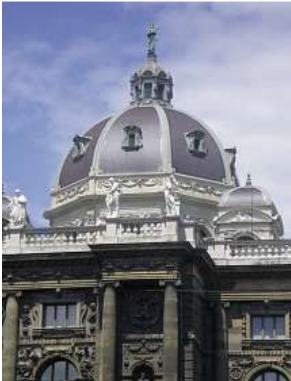
Abb. 17: Kunsthistorisches Museum, Ostseite: Kuppel mit Zinkrippen und Schieferdeckung nach, Steinfassaden unterhalb der Attika vor Restaurierung (Foto M. Koller).
