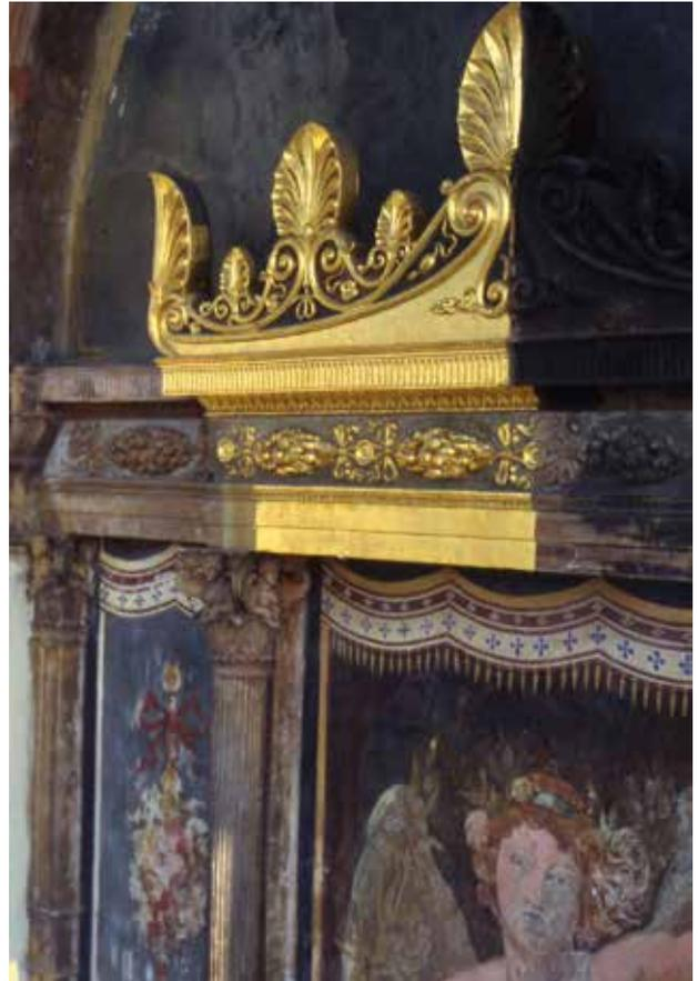
Abb. 15: Wien 1, Akademie der bildenden Künste, Südfassade von Theophil Hansen 1877, Fresko von Eisenmenger mit Rekonstruktionsprobe der Rahmenvergoldung 1990, © Manfred Koller
