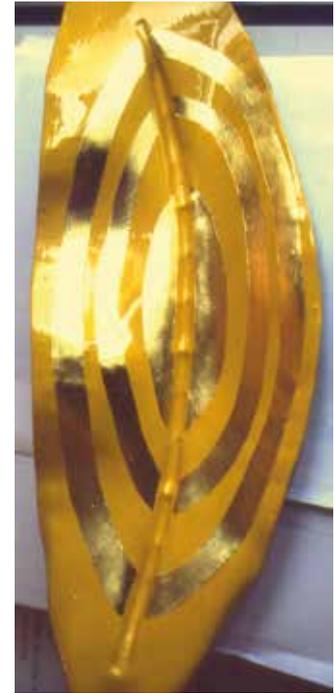
Abb. 24: Wien 1, Sezession von J. M. Olbrich 1898, Lorbeerkuppel nach Rekonstruktion der Vergoldung 1986, © Manfred Koller
