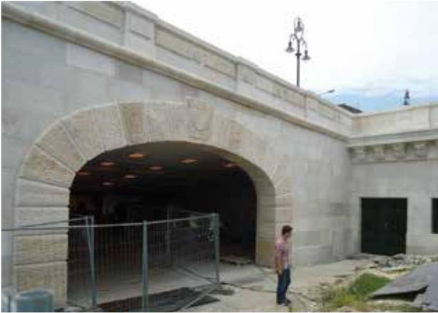
Abb. 8 Margaretenbrücke, Brückenkopf – Eingang in die HÉV-Station Neue Bossierung, © Peter Bogner
