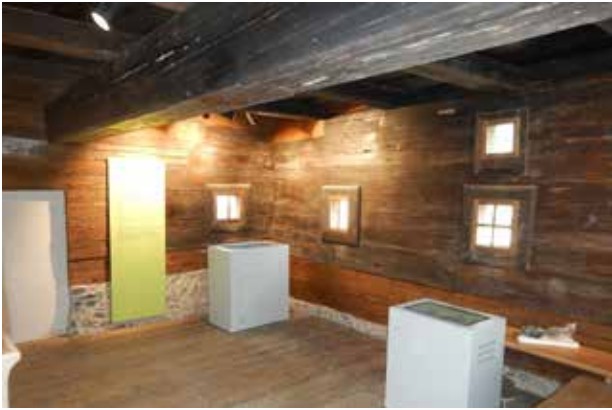
Abb. 2a: Stube nach der Fertigstellung: Farbliche Differenzierungen lassen Ergänzungen der Holzkonstruktion erkennen, 2019, Foto: Zechner, 2019
