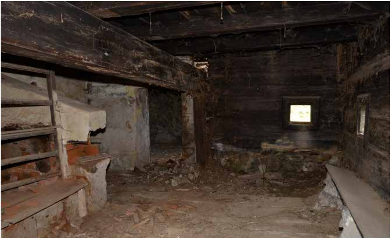
Abb. 2b: Vorzustand der Stube: Starke Schäden an Holzbauteilen und fragmentarisch vorhandene Ausstattung, 2015, Foto: Kühtreiber
