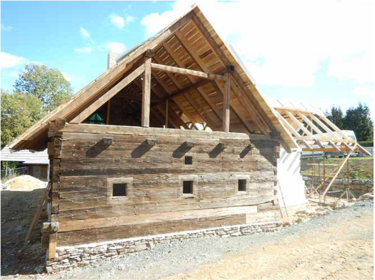
Abb. 3: Blick in den noch offenen Dachstuhl mit den statisch bedingten Ergänzungen der Sparren, 2018, Foto: Zechner
