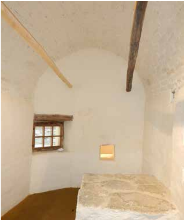
Abb. 4a: Blick in die frisch gekalkte Rauchküche nach Fertigstellung, 2019, Foto: Zechner
