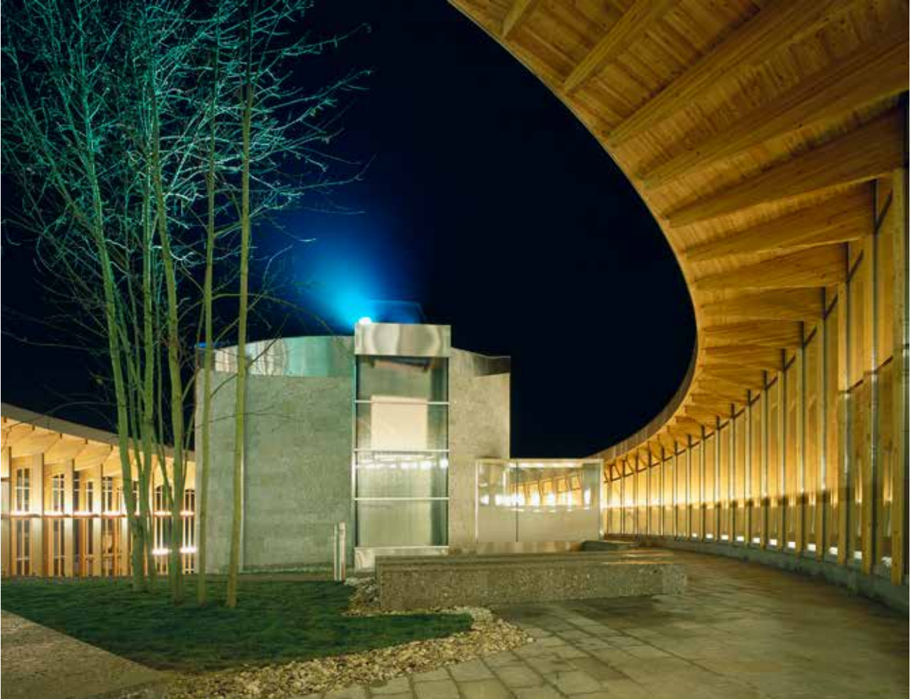
Abb. 1: Ernst Beneder, Anja Fischer, Neubau der Pfarrkirche in Gallspach, 2005, Foto: Margherita Spiluttini Verlegung des Kirchenraumes in den Ortsraum, räumliche Umschließung des früheren Friedhofs mit der Führung des Kreuzweges um die nach Teilabbruch der historischen Kirche verbliebenen Bauteile (Turm und Apsis als Aufbahrungshalle).
