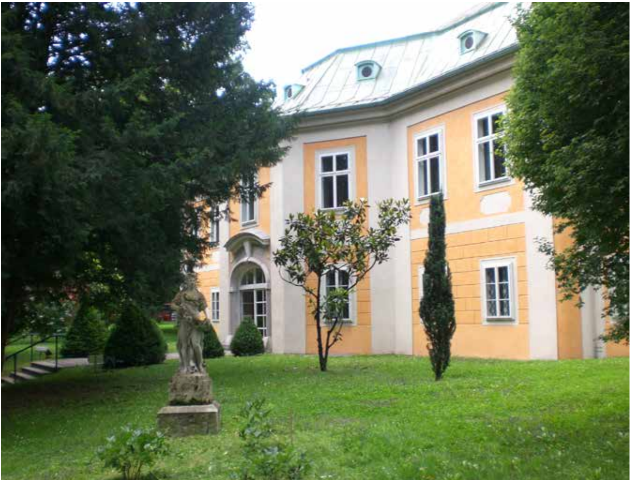
Abb. 2: Der Bergschlössl-Park. Auf einem Teil dieses Areals errichtete der Linzer Baumeister Johann Michael Prunner 1717/18 das Bergschlössl für den ständischen Syndikus und Sekretär Johann Jakob Mäderer von Ehrenreichsron. Der Barockbau kam 1777 in den Besitz des Jesuitenkollegs Nordico, das einen botanischen Garten anlegte, der wegen seiner Pflanzenvielfalt schnell bekannt wurde. Bildnachweis: Wikipedia.
