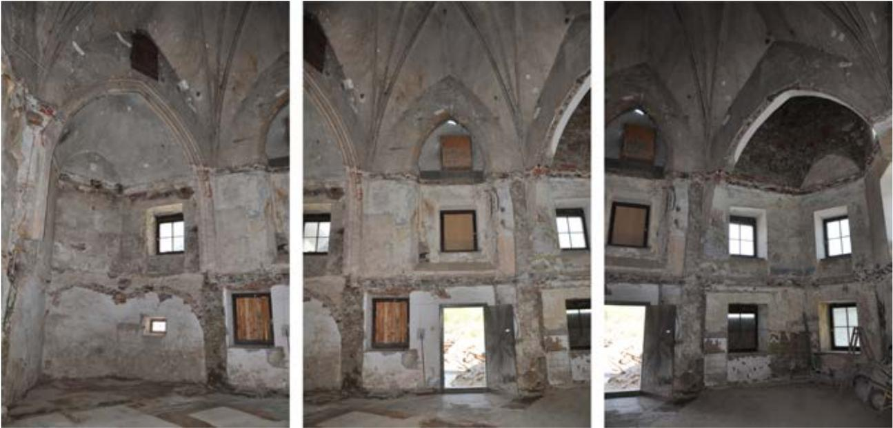
Abb. 8: Innenwände, Wandabschnitte W6, W1 und W2 nach Entfernung der Einbauten von 1794–1817. © Zechner Denkmal Consulting GmbH]
