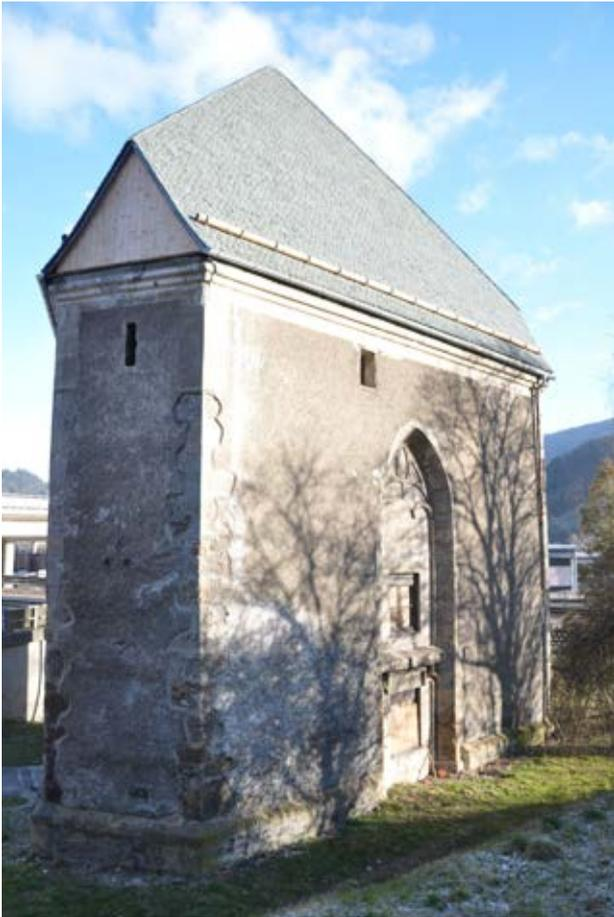
Abb. 10: Ansicht von Südwesten mit teilweise erhaltenem Maßwerkfenster und Schulterbogenportal vor Restaurierung der Fassaden.
