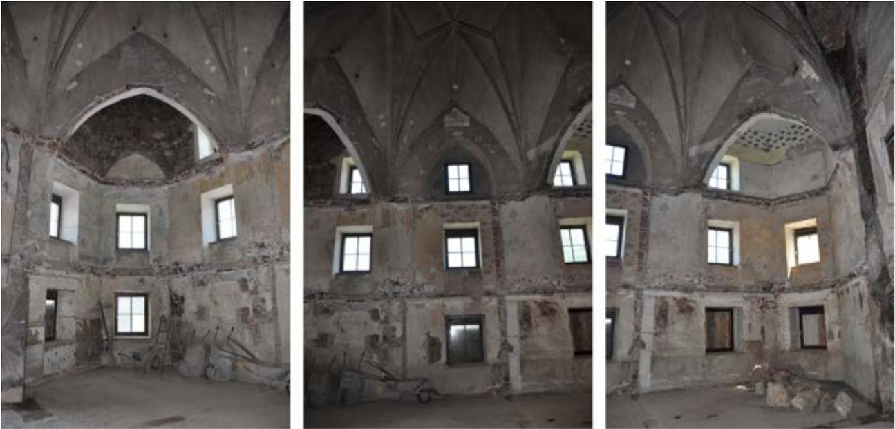
Abb. 9: Innenwände, Wandabschnitte W2, W3 und W4 nach Entfernung der Einbauten von 1794-1817. © Zechner Denkmal Consulting GmbH]]
