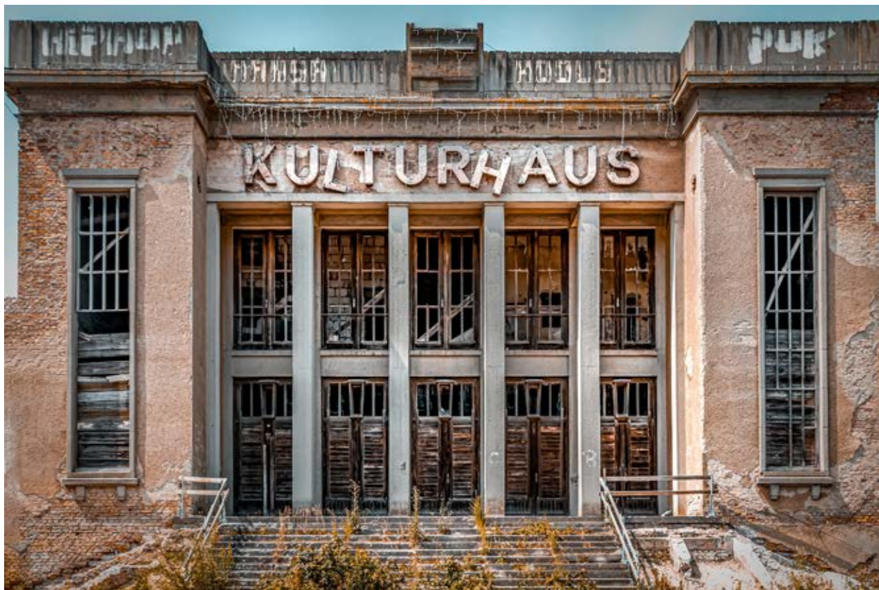
Abb. 1: Die EU verlangt bis 2030 die klimaneutrale Renovierung aller Altbauten, zunächst bis 2028 der öffentlichen Gebäude. Die dena-Leitstudie Aufbruch Klimaneutralität liefert dazu als Beispiel das Bild eines denkbar ungeeigneten Gebäudes, dessen dreidimensional gestaffelte Fassade nur schwierig wärmedämmend außenisoliert werden kann. Foto © Analogicus Tom /Pixabay
