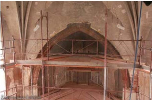
Abb. 20: Wiederaufbau der fehlenden Ziegelbögen © [Zottmann GmbH, Heiligen Geist Kapelle Bruck an der Mur, Bild 5, URL: <https://www.zottmann.at/tag/bruck-an-der-mur/>] (Zugriffsdatum 08.10.2021)].
