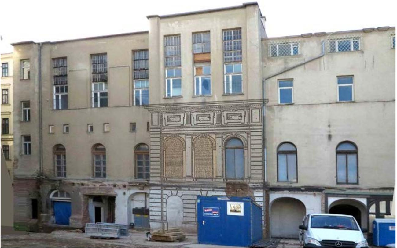
Abb. 11: Ehem. aufgestockte Garten/Hoffassade nach dem Wiederaufbau, vgl. Abb. 7. Über den Mittelrisalit ist die ursprünglich (unaufgestockte) Fassade als Zeichnung darübergelegt. Foto Gerhard Hertenberger März 2020, Bearbeitung Kupf
