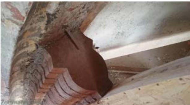
Abb. 21: Wiederaufbau der fehlenden Ziegelbögen © [Zottmann GmbH, Heiligen Geist Kapelle Bruck an der Mur, Bild 4, URL: <https://www.zottmann.at/tag/bruck-an-der-mur/>] (Zugriffsdatum 08.10.2021)].
