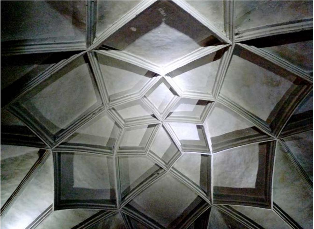
Abb. 23: Sternrippengewölbe vor der Restaurierung © E.mil.mil, CC BY-SA 3.0 AT , via Wikimedia Commons, [https://de.wikipedia.org/wiki/Heiligen-Geist-Kapelle\\_Bruck\\_an\\_der\\_Mur#/media/Datei:Bruck\\_L1400826.jpg](https://de.wikipedia.org/wiki/Heiligen-Geist-Kapelle_Bruck_an_der_Mur#/media/Datei:Bruck_L1400826.jpg)
