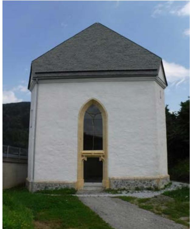
Abb. 14: Die Portalfenstergruppe an der Nordostseite (Portal P2, Wand W3) nach der Restaurierung [Zottmann GmbH, Heilig-Geist-Kapelle Bruck an der Mur, Bild 15, URL: <https://www.zottmann.at/tag/bruck-an-der-mur/> (Zugriffsdatum 08.10.2021)]
